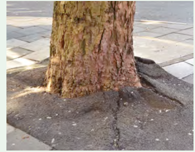
圖 10.13 樹腳被混凝土覆蓋
